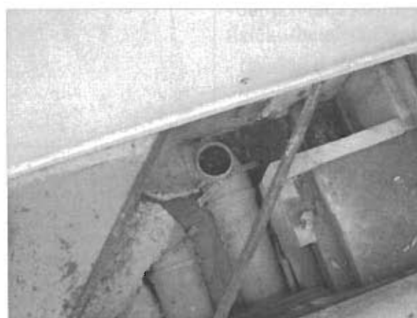
Slika 3. Dovodna cev pre ulaska otpadne vode u separator nakon emajliranja
