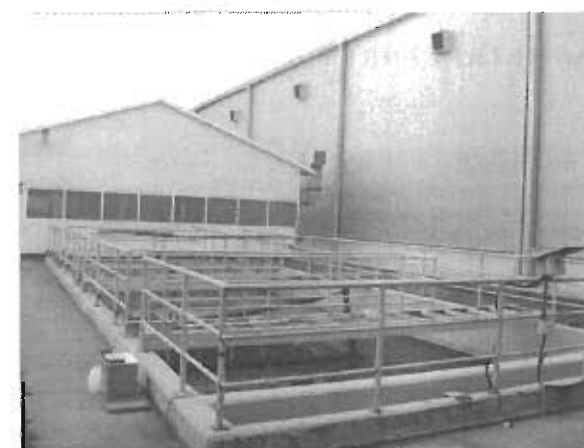
Slika 2. Sedimentacioni bazen za tretman otpadne vode
